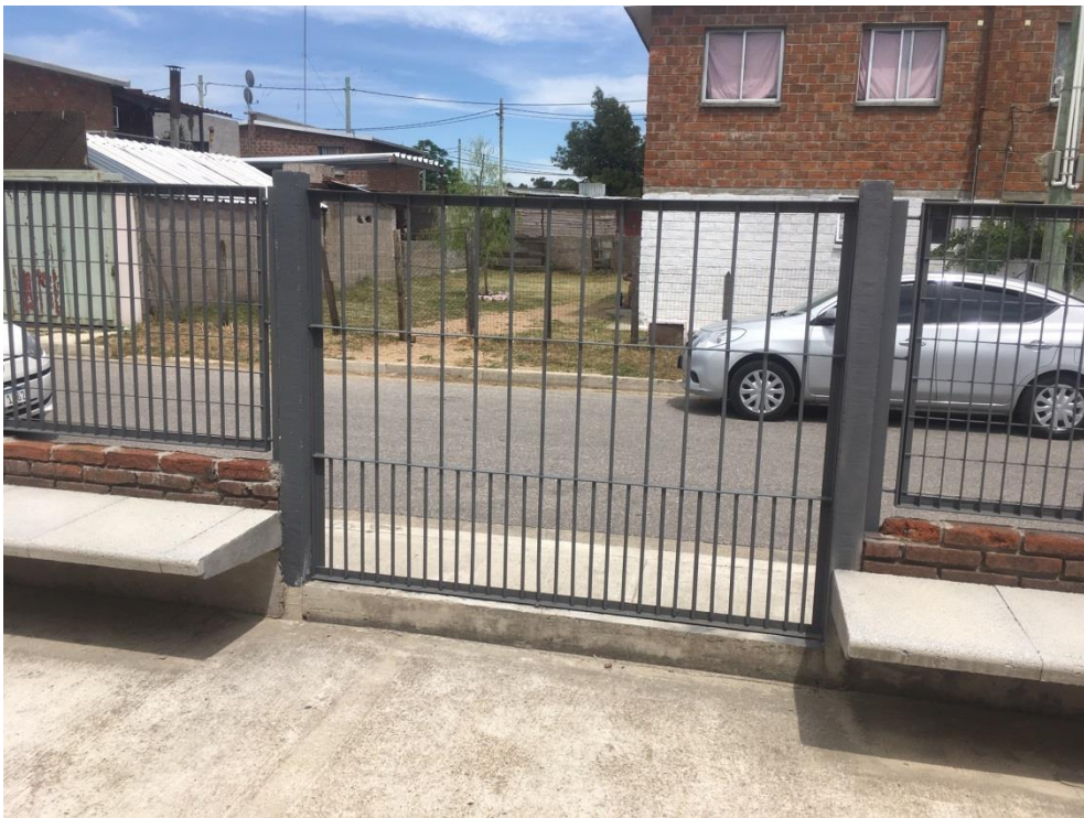
Tramos de tejido perimetral sustituidas por reja
